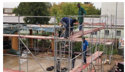
Schon im Sommer 2014 halfen Flüchtlinge aus Afrika auf der Baustelle.
